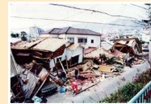
阪神・淡路大震災 倒壊した古い家屋（神戸市灘区）
