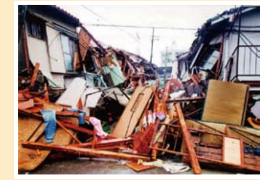
阪神・淡路大震災 道路の閉塞（西宮市）
