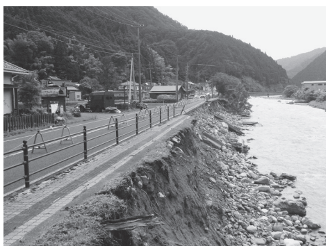
平成30年7月豪雨の被害(上市場)
